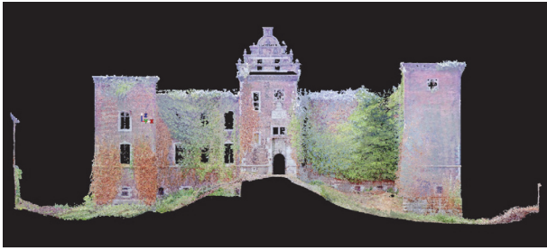
Abbildung 9. Südostansicht der Kommende als Orthobild aus den registrierten Punktwolken des Laserscanners
